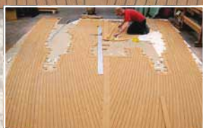
Ett nästan färdigt däck utlagt med plankor.
